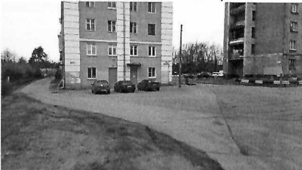
Фото № 8. Пути движения к объекту
